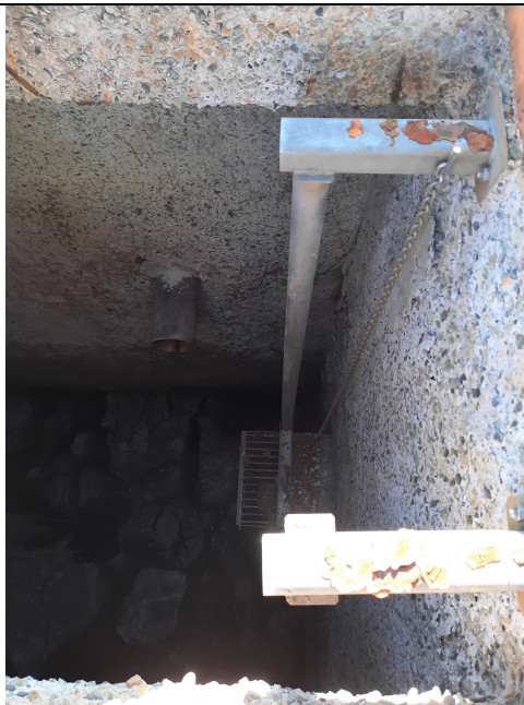
Pohled do mokré jímky ČS – degradace betonu
