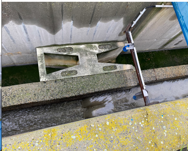
Parshall – navzdouvání hladiny vody v měrném objektu P2
