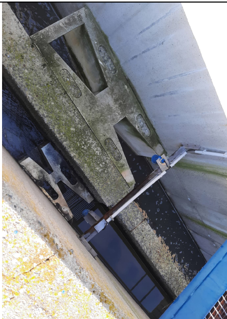
Parshall – vlevo nevyhovující P2, vpravo P4
