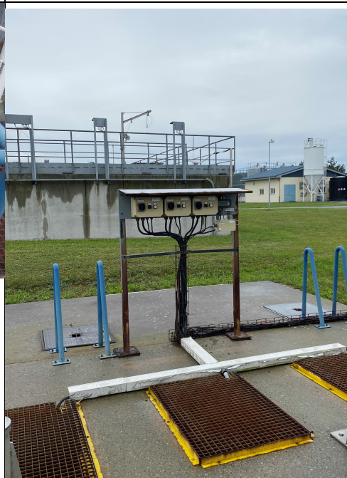
Elektroinstalace – rozvaděč - čerpací stanice
