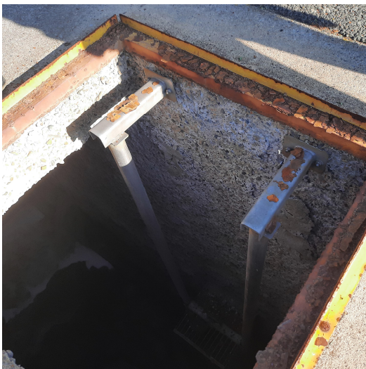
Jeden ze vstupních otvorů do mokré jímky ČS – koroze rámu poklopu
