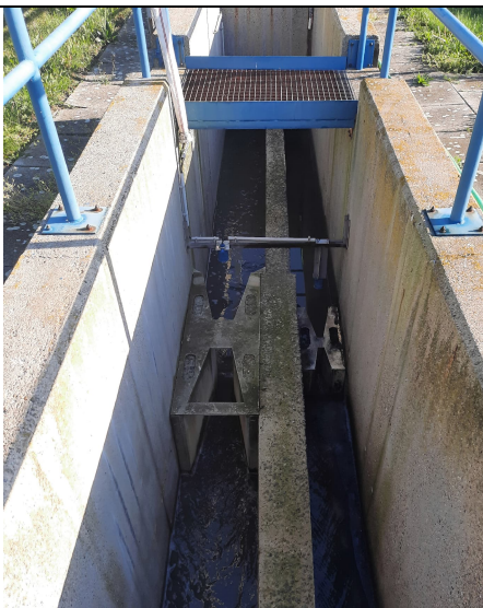
Parshall – vpravo nevyhovující P2, vlevo P4, pohled proti proudu
