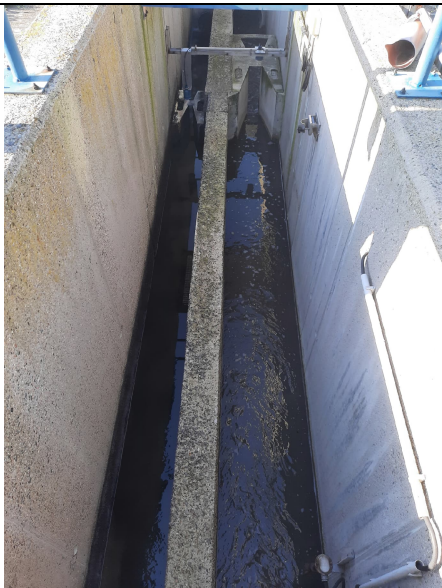
Parshall – vlevo nevyhovující P2, vpravo P4, pohled proti proudu
