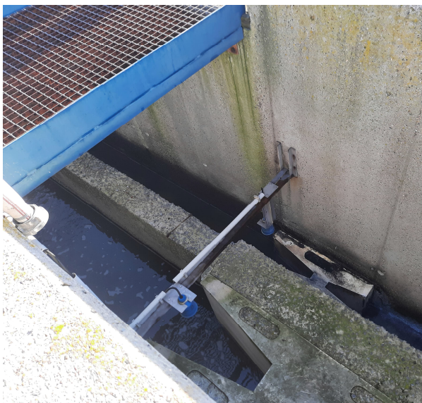
Parshall –vpravo nevyhovující P2 s viditelným zúžením žlabu
